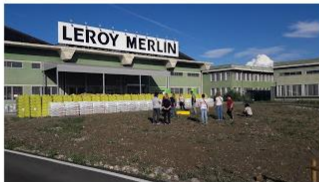
Un momento della preparazione del terreno
